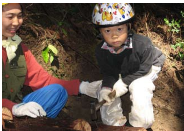
山の中の橋造りでの釘打ち手伝った
