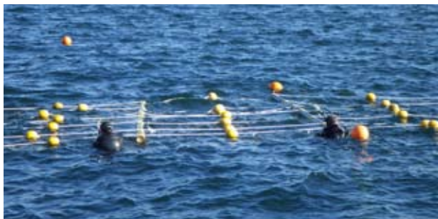
岸壁から 10 m 程に浮かべた筏にダイバーが据え付ける
